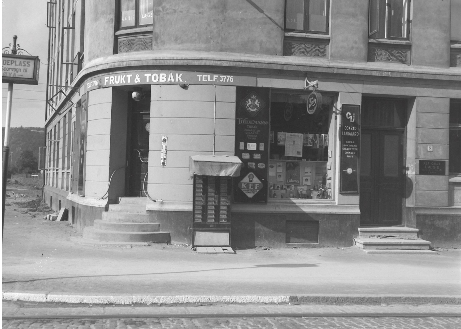
Elgeseter gate 8 på hjørnet med "Sykehusveien".1941
